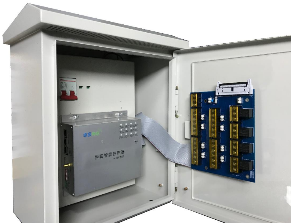
图 3-4 控制箱内主机与接线板连接图
