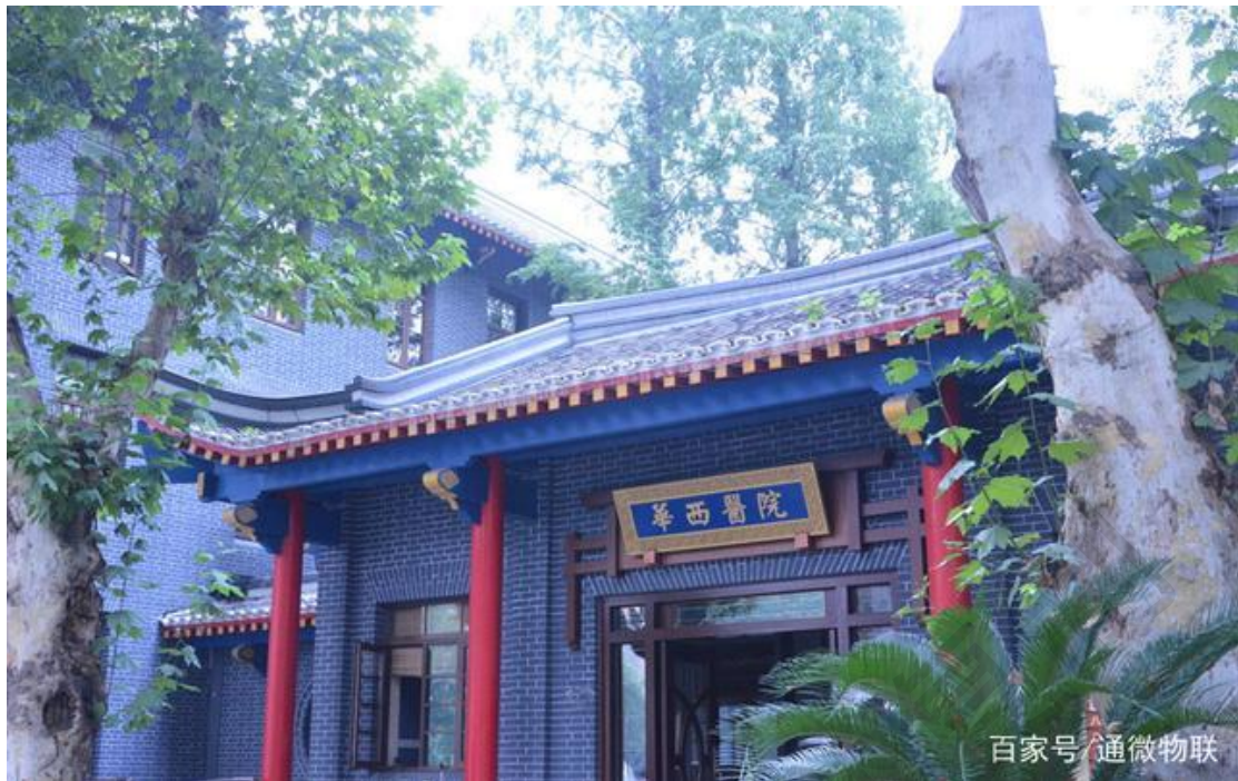
成都华西医院项目实景
